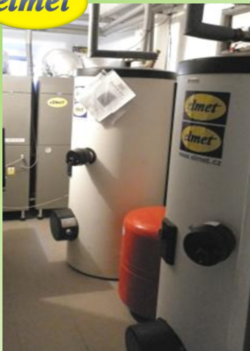
Instalace dvojice tepelných čerpadel a akumulčních nádrží v „Divišově vile“
