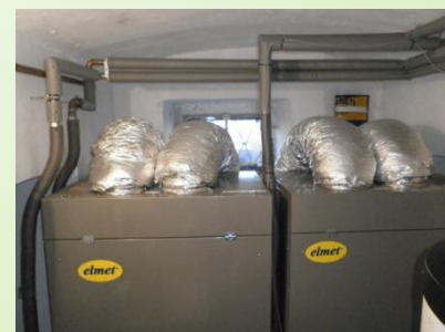
Příklady instalace tepelných čerpadel ELAIR 10UT
